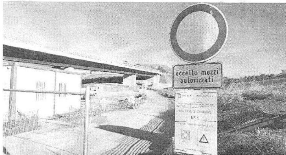
Il cantiere del viadotto Scorciavacche sulla Palermo-Agrigento. (FOTO ANSA)
